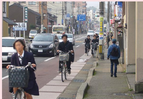
バス専用レーンを活用した 自転車走行指導帯整備
