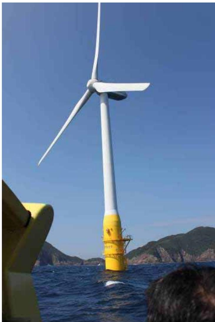
図3: 柁島沖に設置された浮体式洋上風車（筆者撮影）
